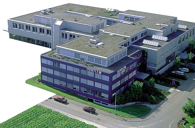
Neues Fabrikationsgebäude in Höri bei Zürich-Flughafen.
